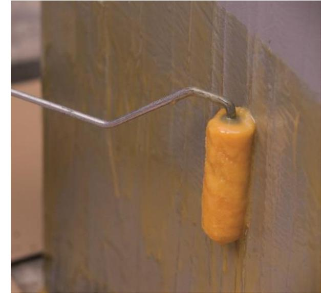
8.- Impregnación del hormigón con resina epoxi fluida **Mapewrap 31**.
