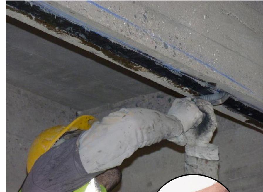
La colocación de 1 laminado Carboplate E 170W de 50mm de ancho y 1,2mm de espesor equivale aproximadamente a la colocación de una barra de acero de 12mm de diámetro...
