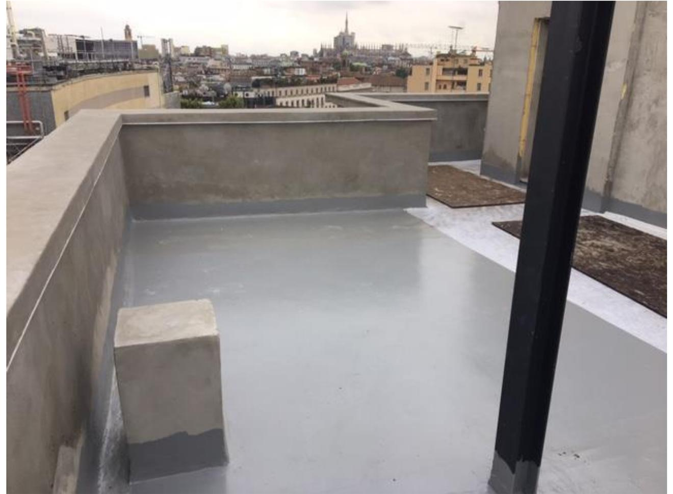
Después de la aplicación de **Purtop Easy** debe protegerse con acabado alifático **Mapecoat PU 20 N**
