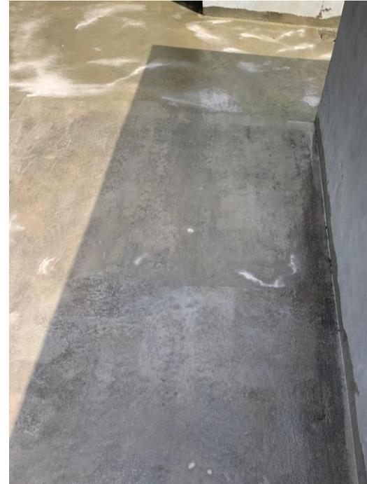
Aplicación de imprimación epoxi **Primer SN** filerizada con árido
