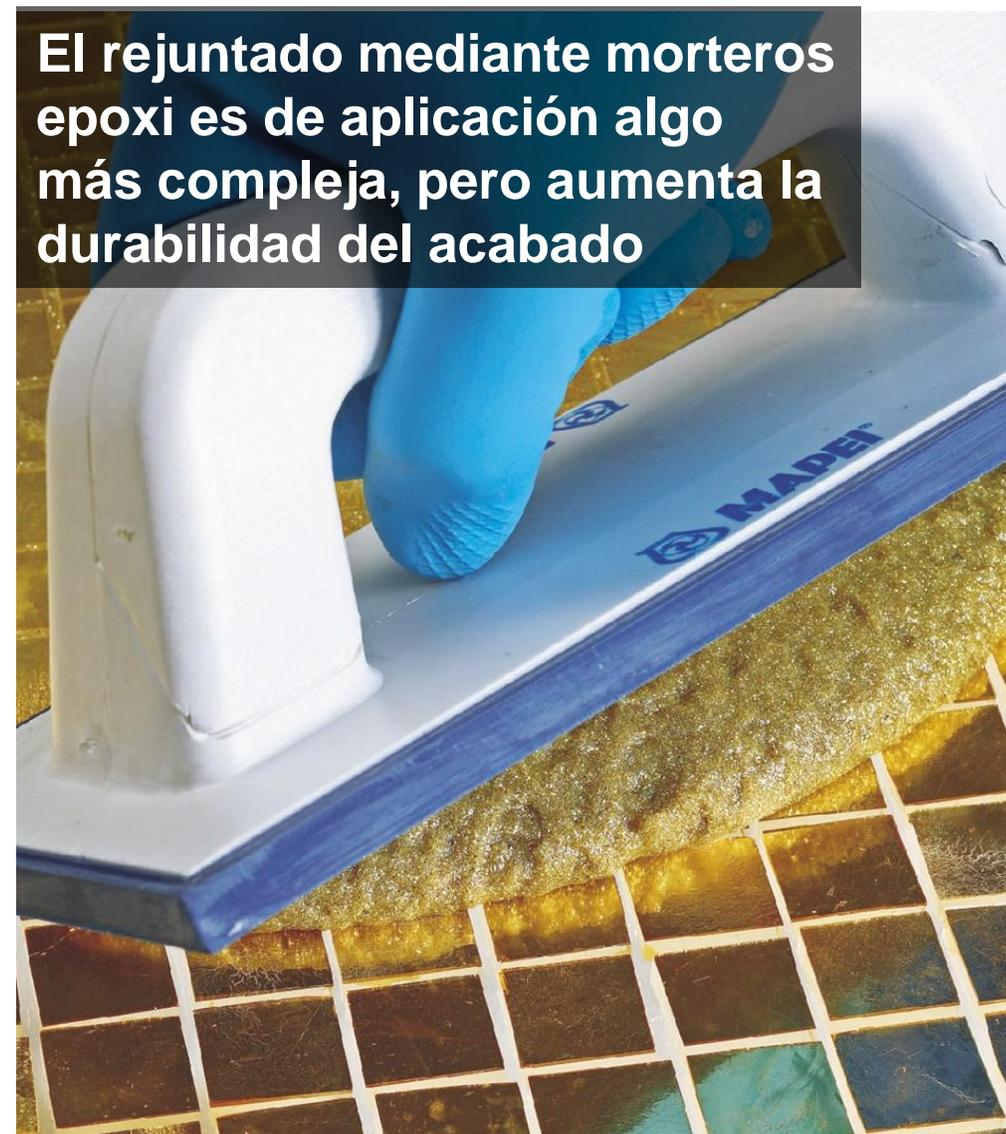
El rejuntado mediante morteros epoxi es de aplicación algo más compleja, pero aumenta la durabilidad del acabado
