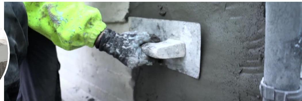
Reparaciones en estructuras de con morteros de reparación estructural Mapegrout
