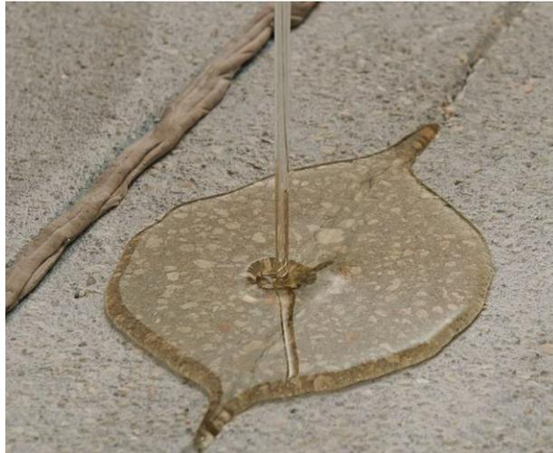
Inyección de fisuras con resina epoxi Epojet
