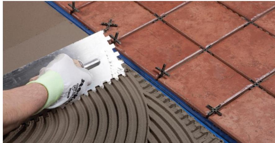
4.- Colocación y rejuntado del revestimiento cerámico
