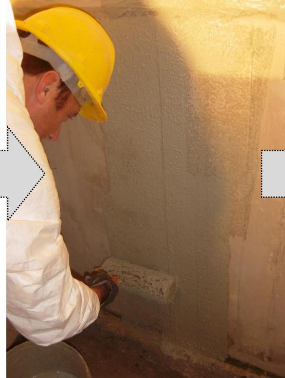
Aplicación de **Mapelastic Foundation** después de aplicar **Planitop HDM Maxi** en fábrica
