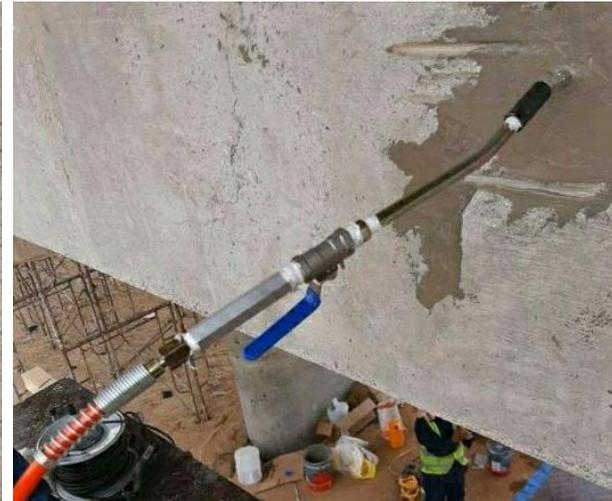
Armado de membrana impermeable con malla Mapenet 150
