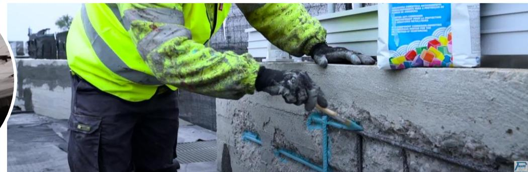
Reparación con mortero estructural Mapegrout T 60 0 T 40
