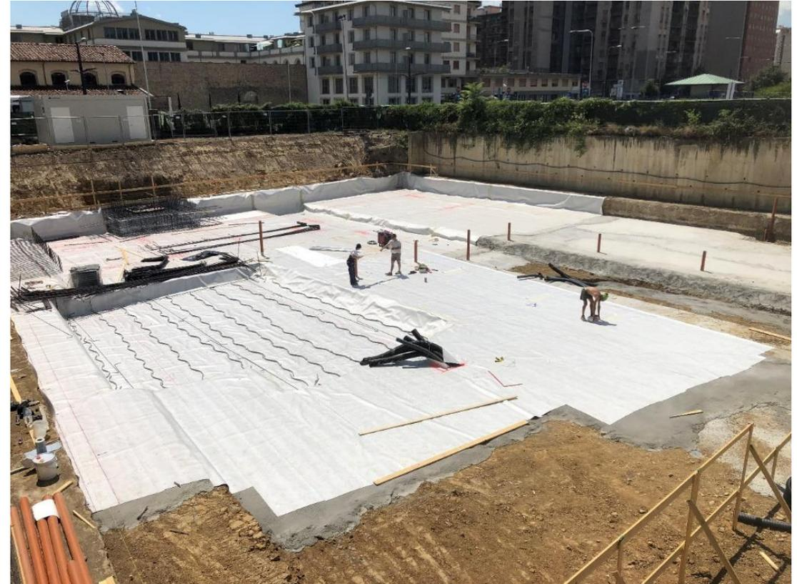
Extensión de lámina **Mapeproof FBT** con solapes longitudinales
