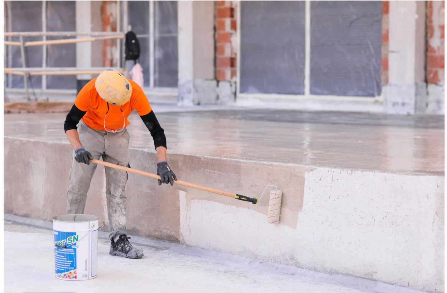
Aplicación de imprimación epoxi **Primer SN** filerizada con árido
