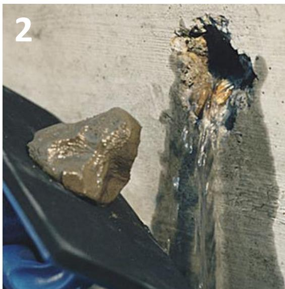
**Lamposilex:** Mortero ultrarrápido (tiempo trabajabilidad 1min) para obturación de vías de agua. Amasar ligeramente y formar un tapón para aplicar directamente sobre la vía (repetir la operación si es necesario). En fisuras tratar de abajo a arriba.
